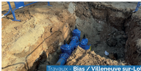
Travaux - Bias / Villeneuve sur-Lot
