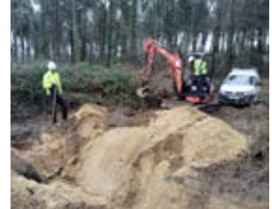
Sondage de reconnaissance en terrain naturel
