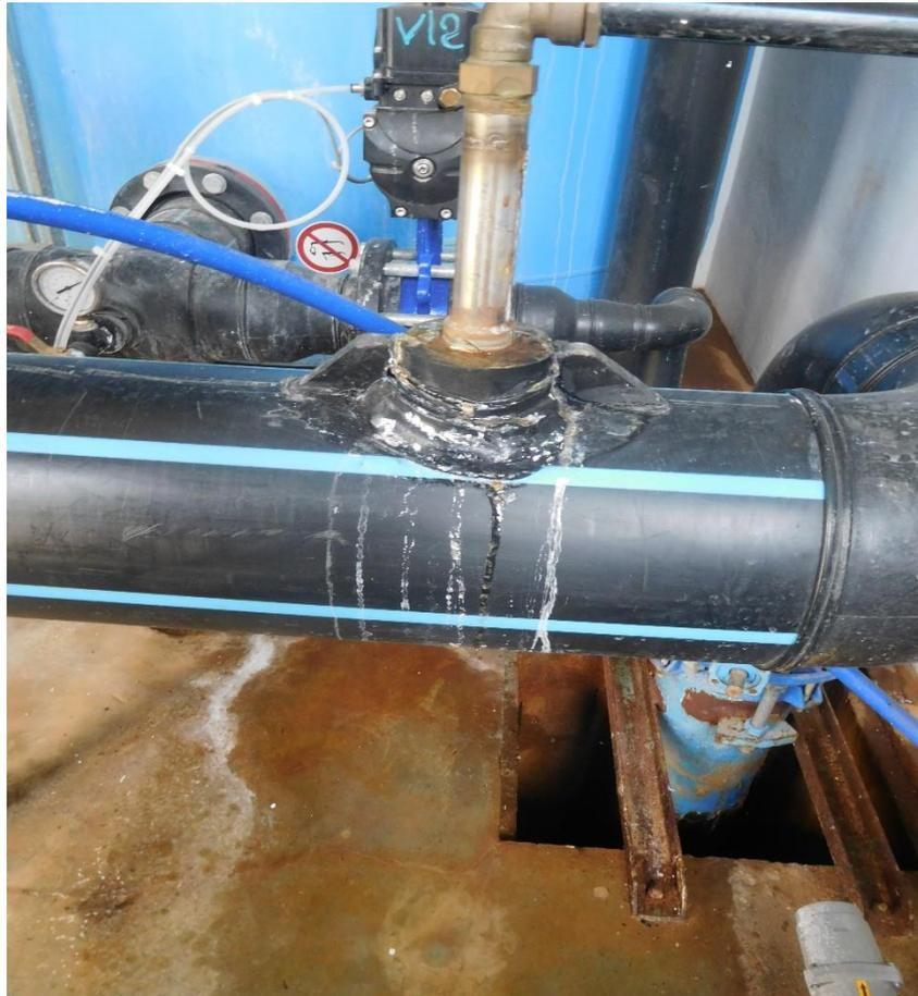
Fuite d'une soupape d'air sur le plafond
