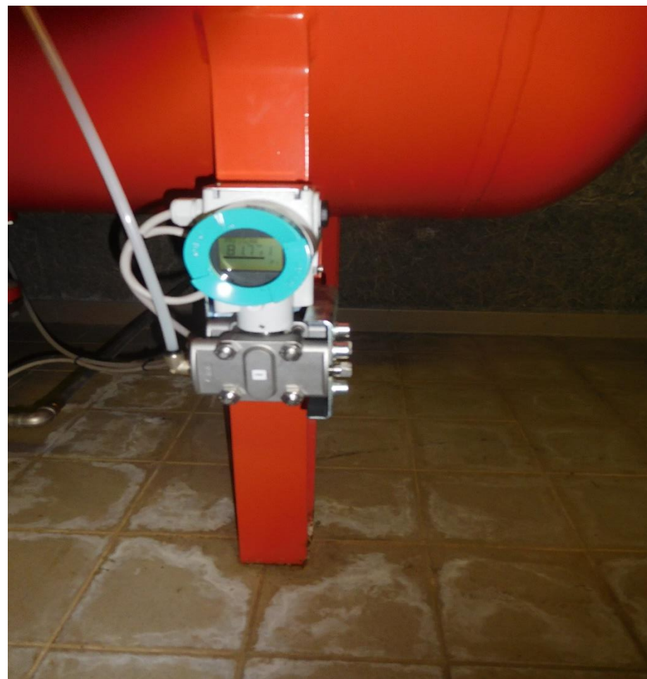
Pose de manomètre différentiel dans les usines
