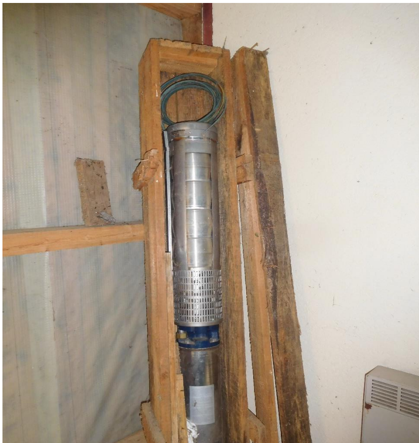
Remplacement de la pompe de forage
