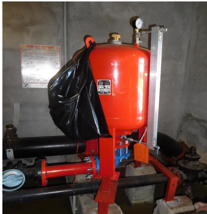
Remplacement ballon au moulin de Safin
