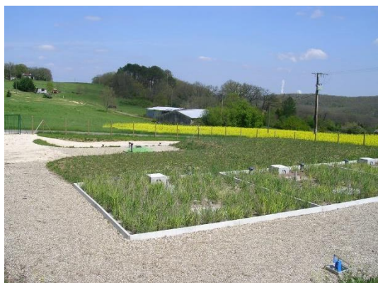
Filtres plantés de roseaux 62 %
