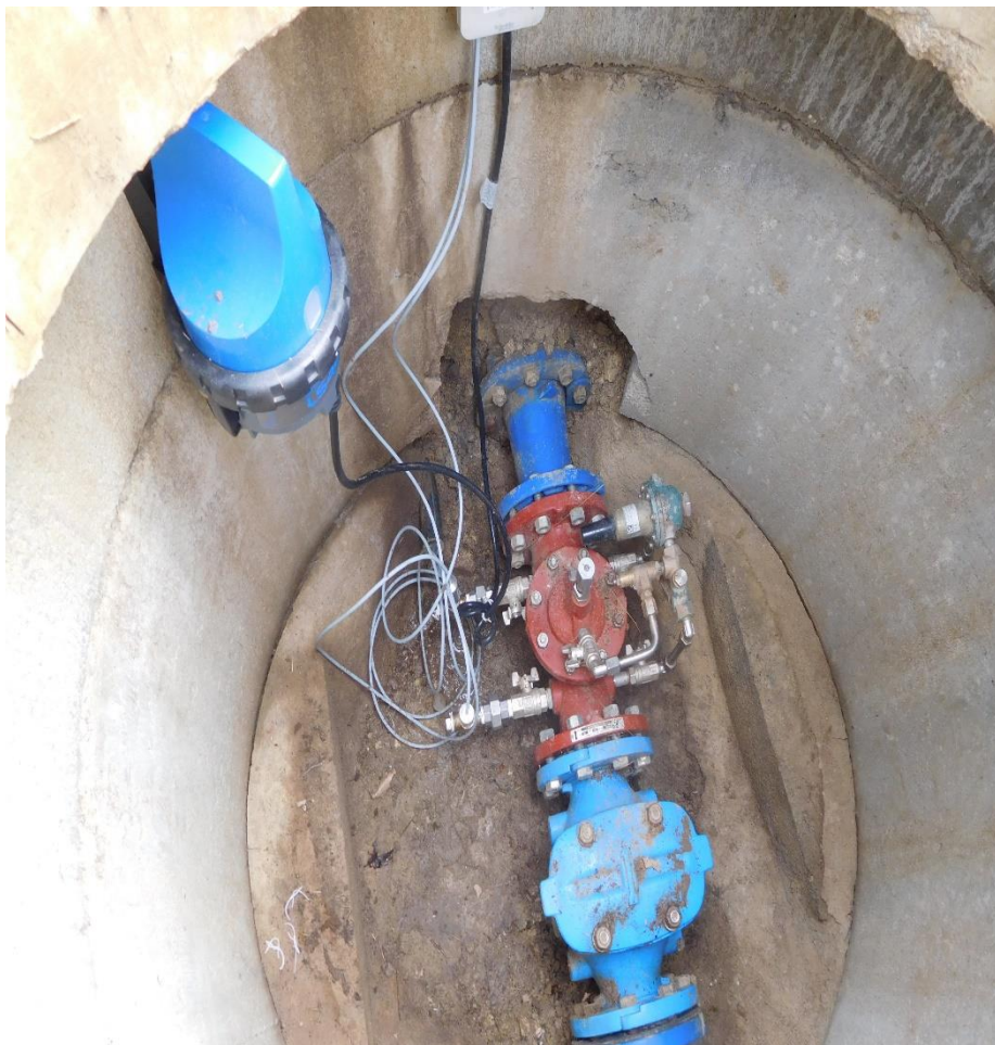
Pose de sonde de pression sur le réseau
