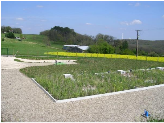
Filtres plantés de roseaux 43 %
