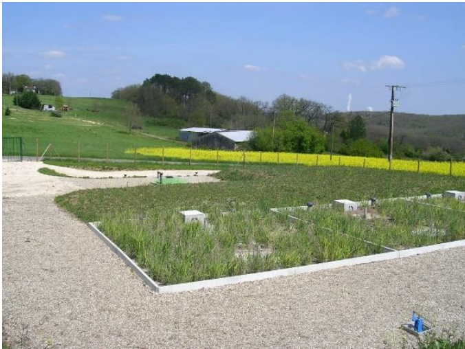
Filtres plantés de roseaux 3 stations 27,3 %
