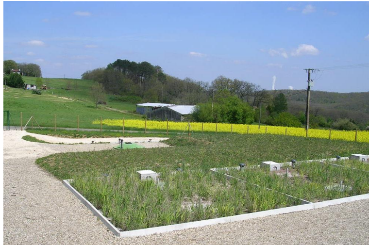
Filtres plantés de roseaux 6 stations - 43 %
