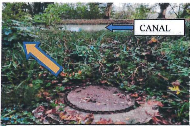
Evacuation des eaux de la STEP. Passage sous le canal 17m. et rejet en Garonne en Diam. 200.
