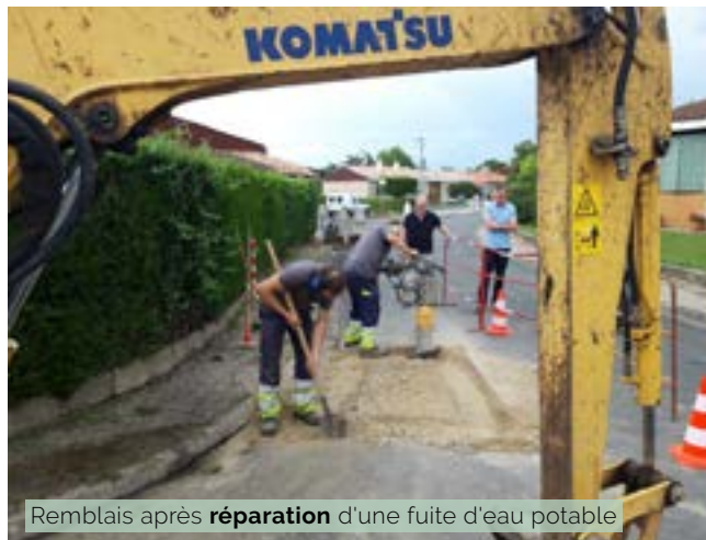
Création d'un branchement d'eau potable
