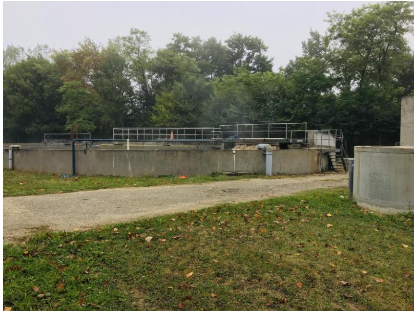
Station d'épuration Penne- Saint Sylvestre
